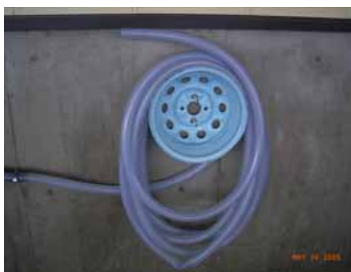
ホースは床面から離して収納。タイヤのホイールを再利用している。
